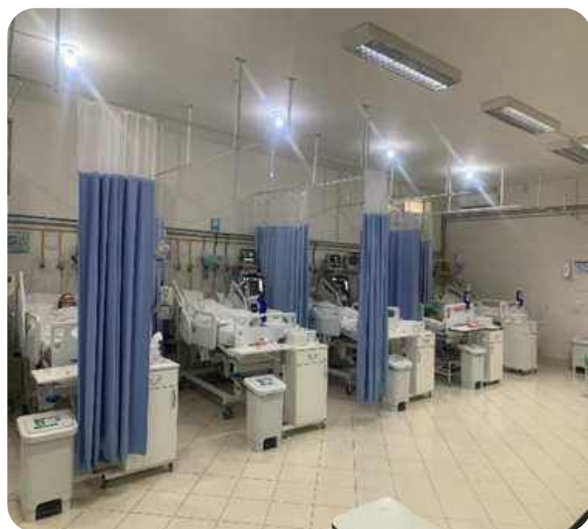
INSTALAÇÃO DE CORTINAS
